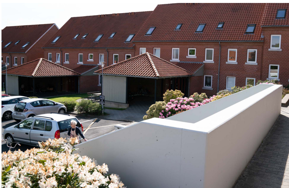
Fællesarealerne er også omfattet af Raackmannsgårdens renovering.
