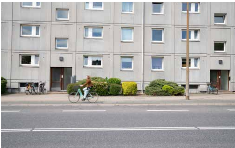
I dag rummer Sofie Amaliegården 111 lejligheder. Efter renoveringen vil afdelingen bestå af 100 lejligheder.
