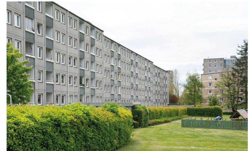
I dag rummer Sofie Amaliegården 111 lejligheder. Efter renoveringen vil afdelingen bestå af 100 lejligheder.
